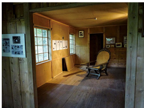
二階の様子。床が落ちていた部分（画面中央）も修繕された
