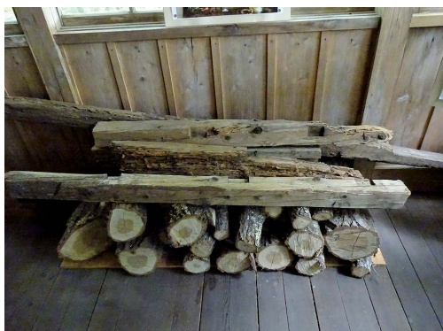
朽ちて取替えられた柱材(薪の上に横置き)。 継ぎ木のため差し替えられた
