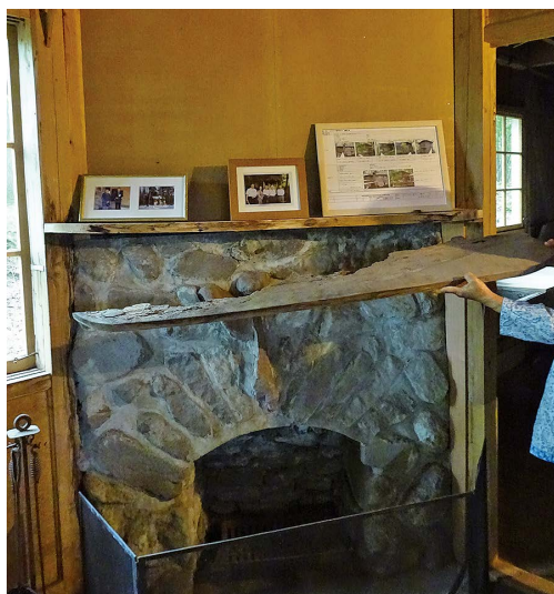
暖炉の破損したカウンターも昔のデザイン通りに修復された
