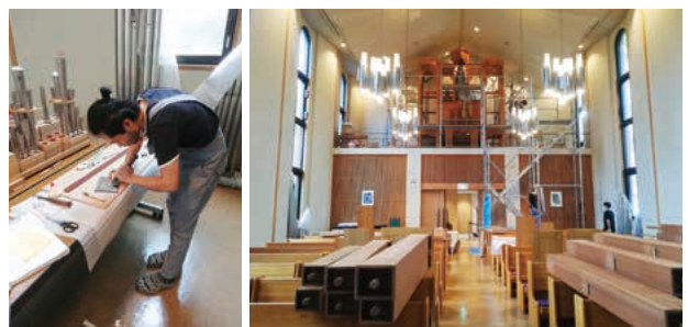
右/オルガンの周りに足場が組みまれ、パイプが次々に外されていきました 左/ふいごの補修に使用するテープを丁寧に調整しています
