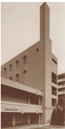
旧大学院棟 外観
