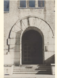
鉄柵と門燈は献納し、 防火用水設置
