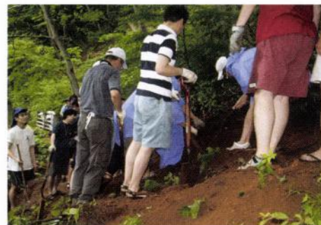
雨の中、プールまでの道の土木作業です
