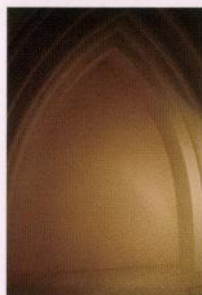
中央のアーチに近づいて見ると十字架のモチーフがかすかに浮かびます。これもヴォーリスの設計に基づいています
