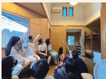
キャビン内エアコン
