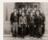
沖電気東洋永和 作業所となる 1945(昭和20)年
